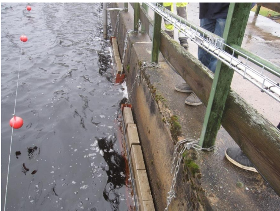
Figur 1 Paneler på dammens uppströmssida
